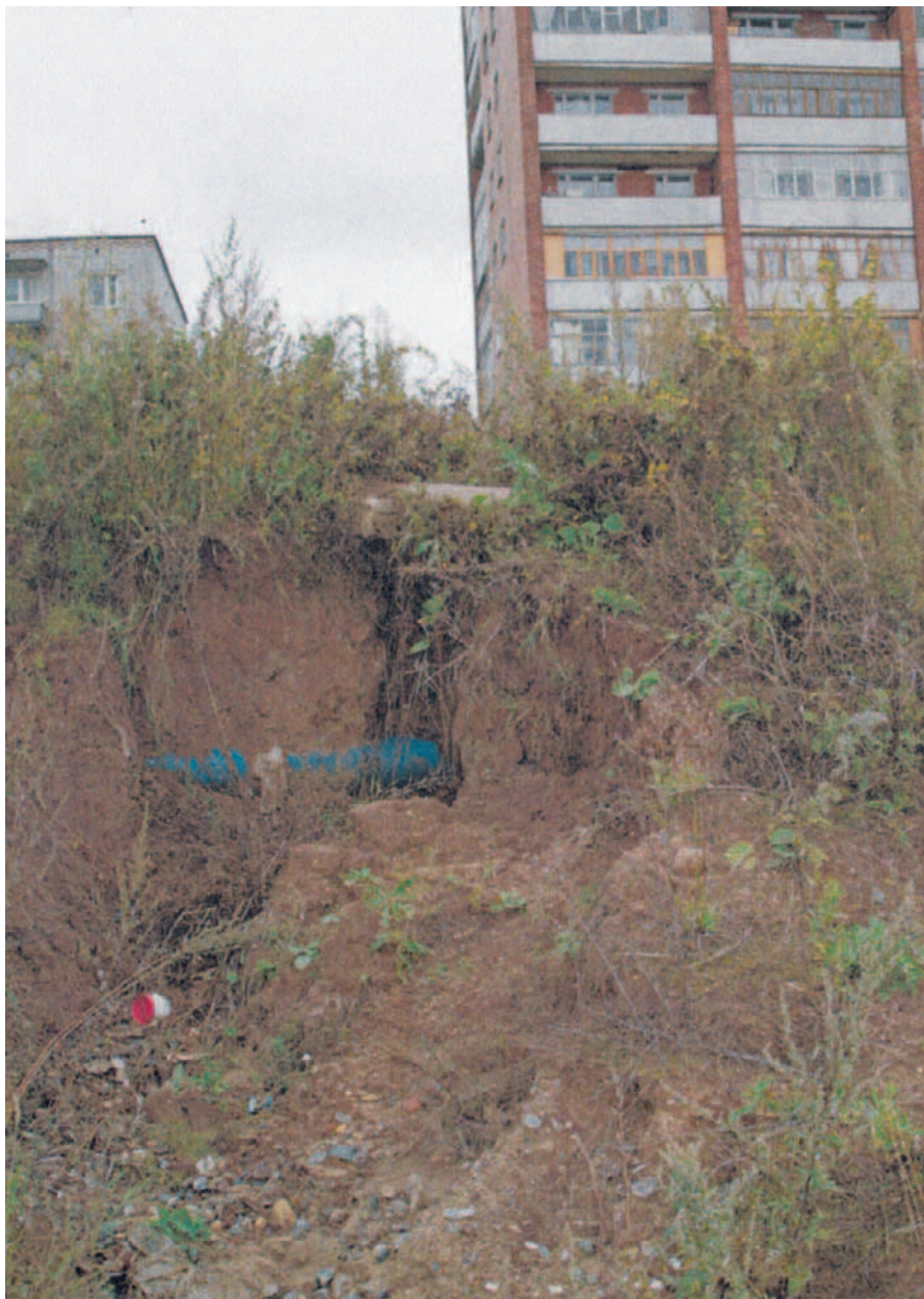
Рис. 53. Состояние откоса у многоэтажки до берегозащиты — было
