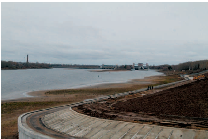
Рис. 22. Подход к шлюзам — стало
