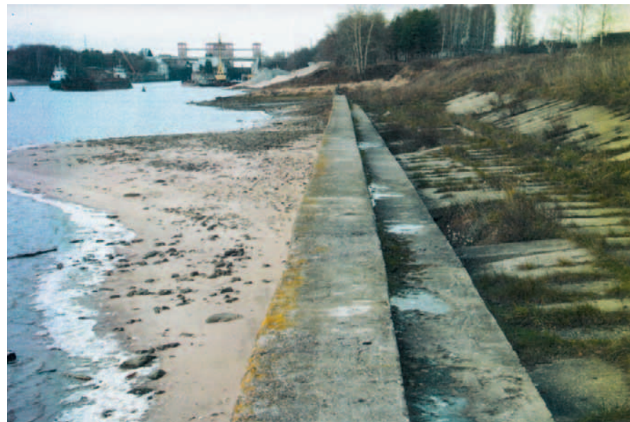
Рис. 43. Состояние защитной стенки — было
