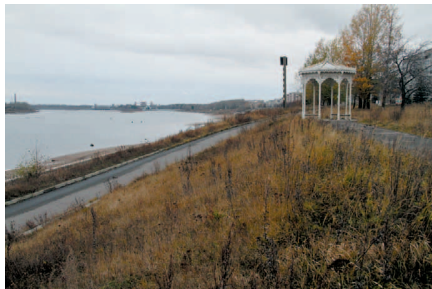
Рис. 20. Нижний бьеф гидроузла — стало
