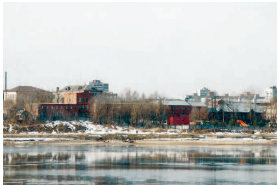
Рис. 39. Защита территории водохранилища — было
