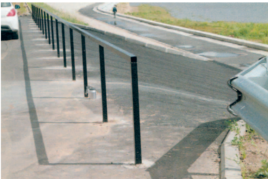
Рис. 46. Элемент благоустройства. Спуск — теперь
